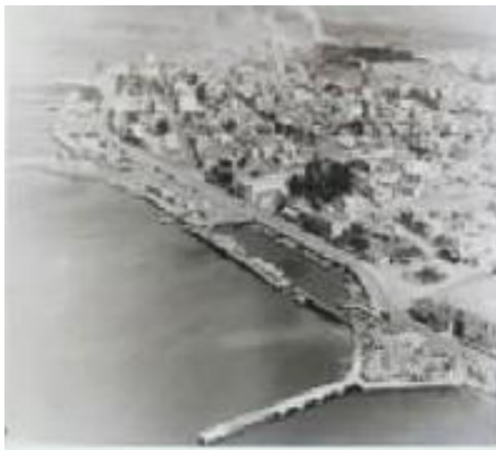
Εικόνα 2.1. Παλαιός Λιμένας Ελευσίνας
