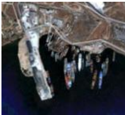
Εικόνα 2.4. Προβλήτας στη θέση «Βλύχα»
